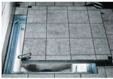
BV instalován v čistící šachtě
