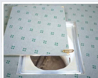
BVA instalovaný v kanceláři (koberec)
